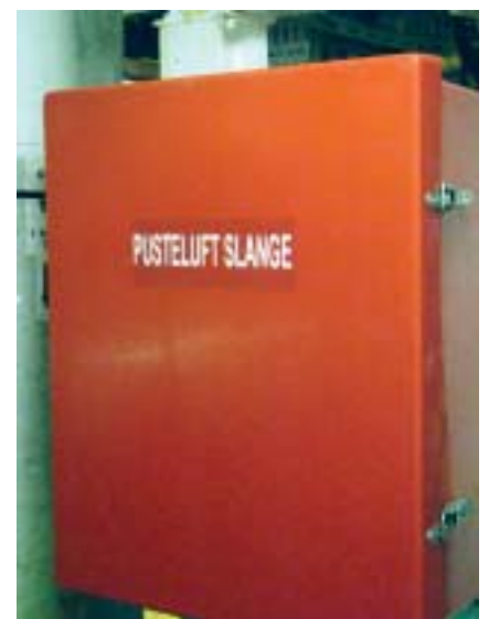
Skapet for pusteluftslangen.
